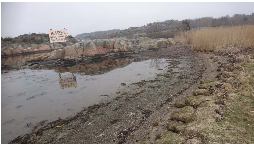
Figur 12. Landfäste för befintlig kabel vid Ganleberget.
